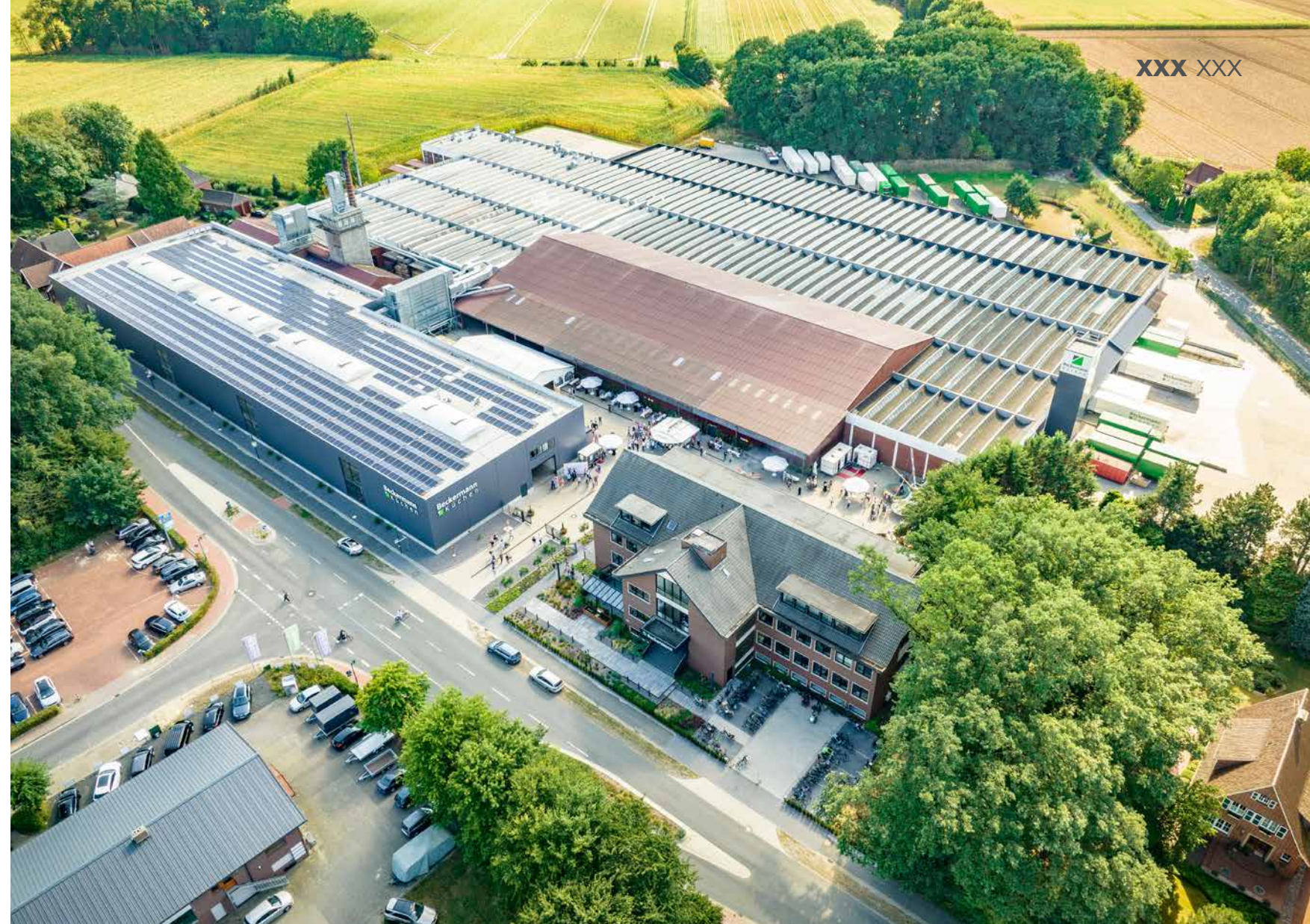
Beckermann blijft investeren in de productiefaciliteiten te Cappeln, met onder meer zonnepanelen op het dak.
